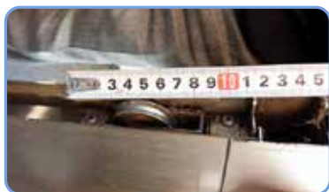
▶ 引き戸の戸車交換
