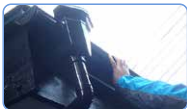
▶ 雨どい修理・交換
