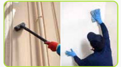
▶ 外壁・室内壁
