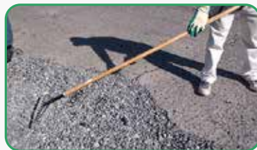
▶ 駐車場穴補修・砂利敷き
