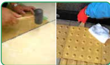
▶ タイル・点字ブロック補修
