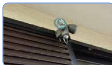
▶ 防犯センサーライト取付け
