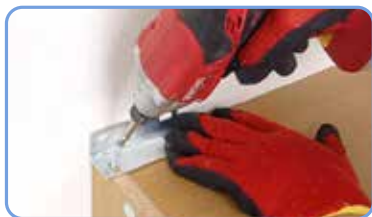
▶ 耐震金具・棚の取付け
