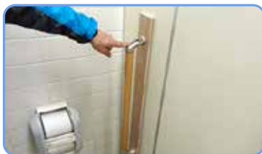
▶ 手すり取付け
